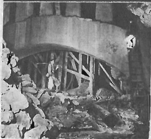
A sinistra: l'impianto di congelamento per l'attraversamento dell'alveo del torrente Algone. A destra: la caverna di Caggi, nella quale si è dovuto costruire un ponte canale di cui si vede l'arco di sostegno in cemento armato.
