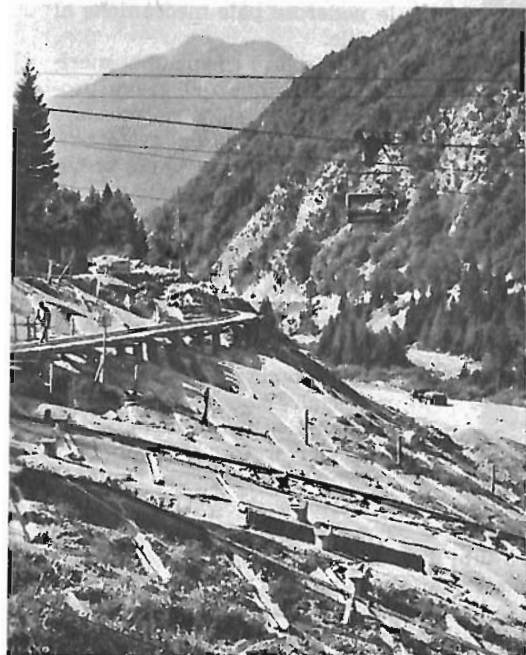
Sopra: zona argillosa consolidata con il metodo elettro-osmotico. Sono visibili gli elettrodi infissi nel terreno. A destra: la galleria di derivazione, del diametro di 5 metri: è in corso di preparazione la gettata del calcestruzzo di rivestimento.
