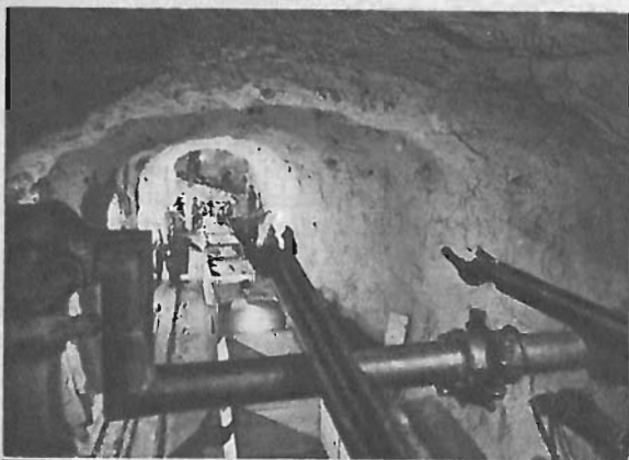
Il « Giumbo », una moderna perforatrice meccanica a più bracci, insieme ai carrelli adibiti allo sgombero del materiale escavato nella galleria.
